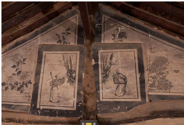
图2 东壁山墙上部壁画裂痕（No.9）
